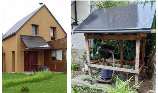
Panneaux thermiques formant une grande marquise au-dessus d'une baie et panneaux couvrant un barbecue.
