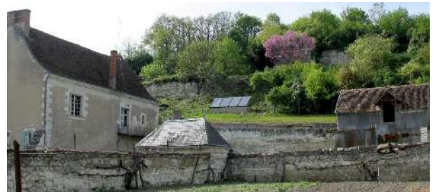
Panneaux installés au sol à Bourré (41). La faible emprise du dispositif et l'éloignement par rapport à la rue rendent tout à fait admissible leur perception.
