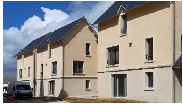
Intégration parfaite de panneaux thermiques sous une couverture au sein du Site Patrimonial Remarquable à Vendôme (41).
