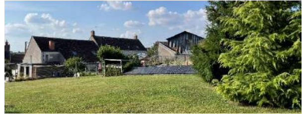
Panneaux installés au sol, dans un jardin à Francueil (37). Leur faible hauteur les rend invisibles depuis l'espace public.
