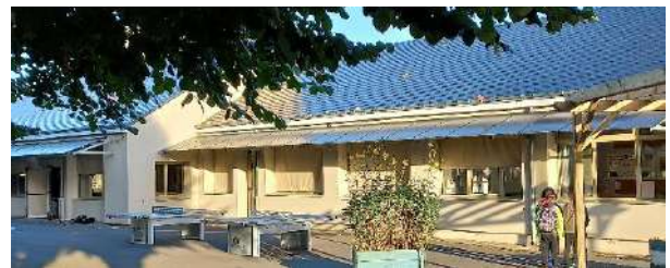
Panneaux photovoltaïques formant de grands brise-soleil le long des fenêtres d'une école à Amboise (37). Les panneaux permettent ainsi d'améliorer le confort d'été de l'équipement.
